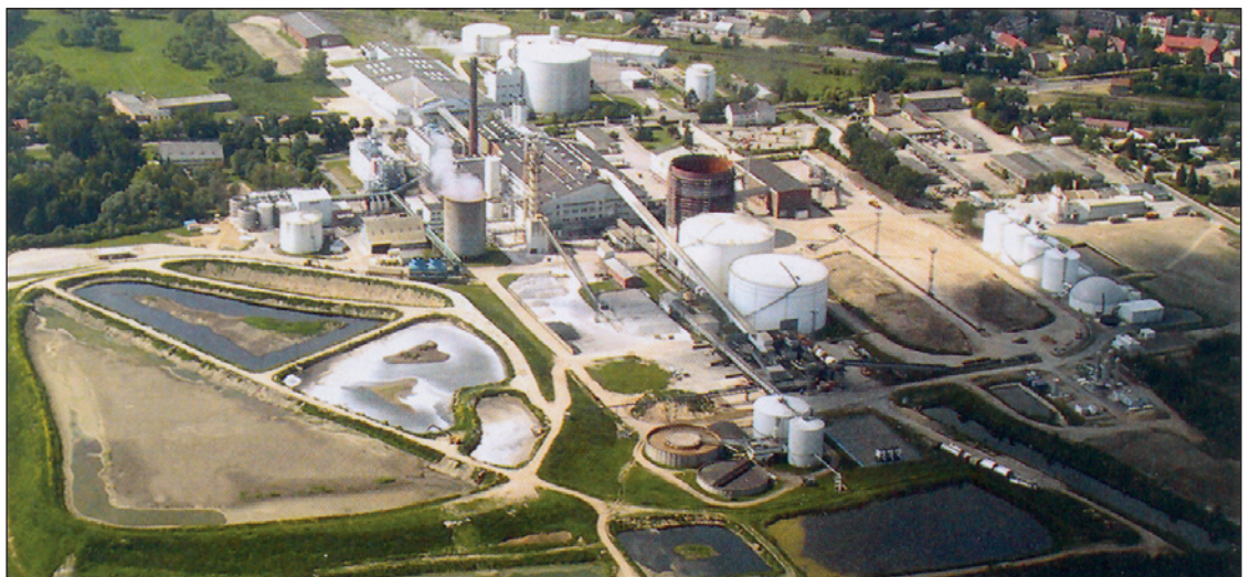
عکس هوایی کارخانه قند Anklam با چهار تخمیرکن - سمت راست در کنار سیلوی چغندر
